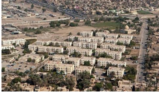
شكل (٢١) مجمع السيدية حيث بدأ البناء بالقالب الثابت والصب الموقعي لأول مرة في العراق
