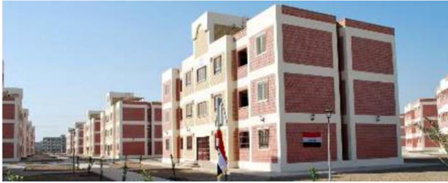
شكل (٢٨) مجمع كص سويلم ففي الحلة المشيد بالهيكل الكونكريتي والتقطيع بالكتل الكونكريتية المجوفه وانهاء الجدران الخارجية بالطابوق الجيري
