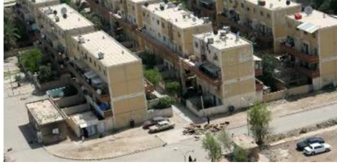
شكل (٢٣) مجمع قرب البياع ويوجد مشابه له في البصرة، البناء بالقطع الجاهزة والتنبيت الموقعي لبيوت (الدبلاكس)
