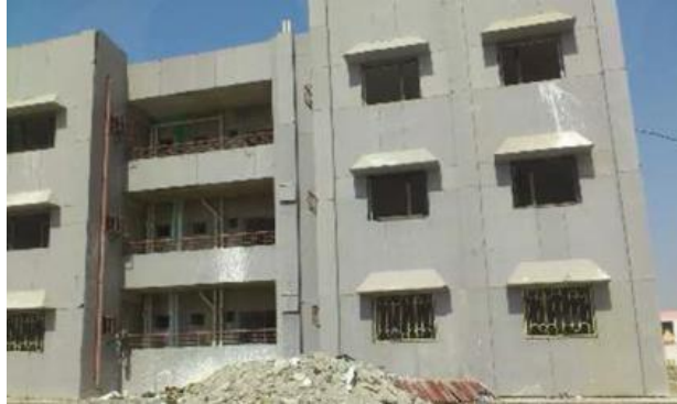
شكل (٢٩) مجمع الحيانية في البصرة مشيد بالهيكل الكونكريتي والتقطيع بالكتل الكونكريتية المجوفه والانهاء بالصفائح الاسمنتية
