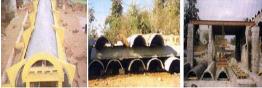
شكل (٣٢) بناء السقوف بالفيروسمنت وبالجهد الذاتي في الهند
