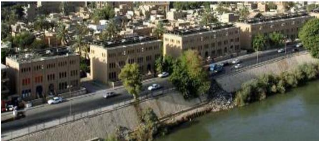
شكل (١٩) مجمع ابو نؤاس وتظهر فيه الواح الطاقة الشمسية على سطوح العمارات
