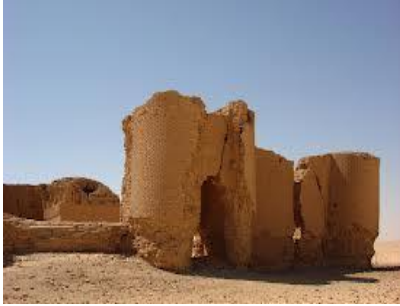
لوح رقم (١) مدخل المبنى
