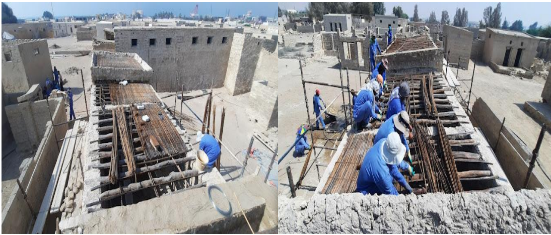
شكل ٩ توضح المباني السكنية وغرف السوق أثناء مشروع الترميم.
