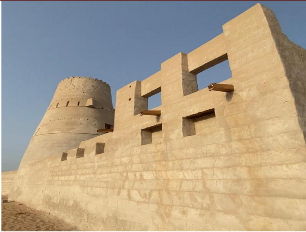
شكل ٥ احد ابراج جزيرة الحمراء بعد الترميم.
