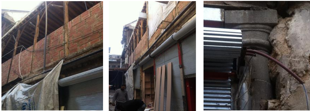
شكل (٢) استخدام مواد البناء الحديثة في مشروع ترميم الأضرار التي لحقت بسوق الحميدية
