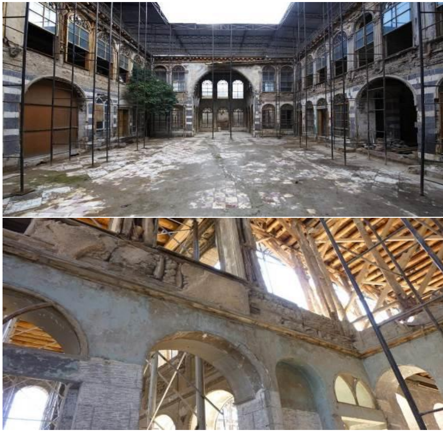
شكل (3) يظهر بيت القوتلي خلال اعمال الترميم والتدخل
